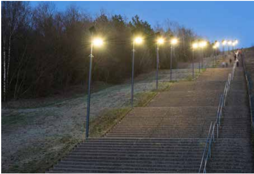
protos Treppe Wilhelmberg / NL
